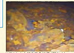
地下タンク内部の腐食状況 (貯油中)
