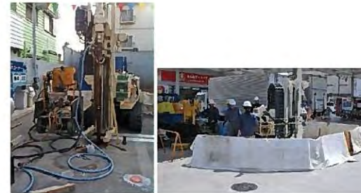
SS営業中浄化工事 (参考写真)
