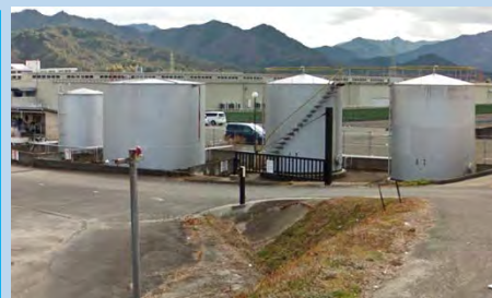
配達業務強化のために油槽所のタンクを増設
