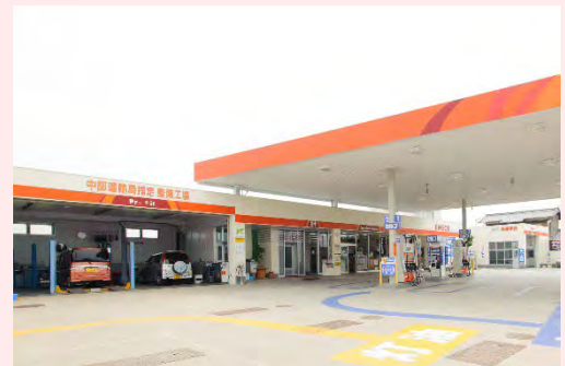
SSIに併設されている車検場
