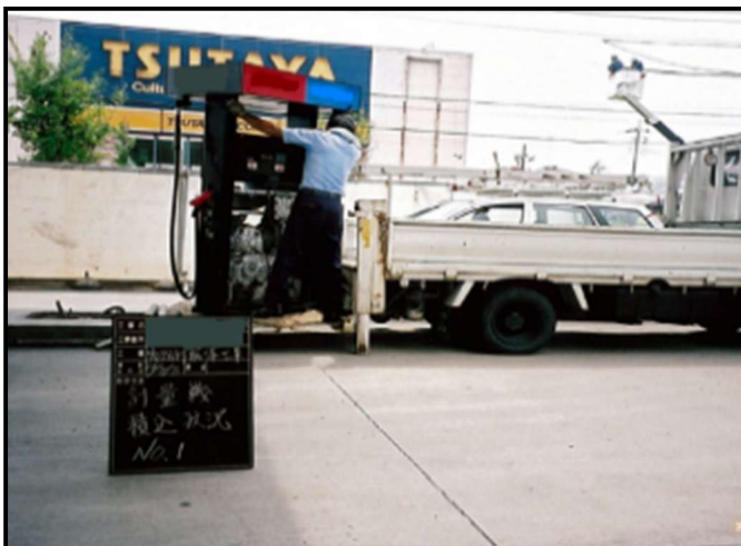
・計量機撤去中
