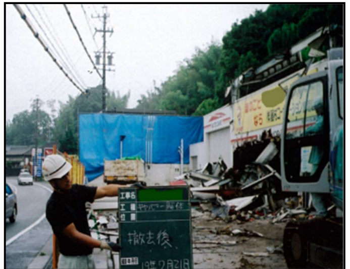
・キャノピー解体(撤去後)
